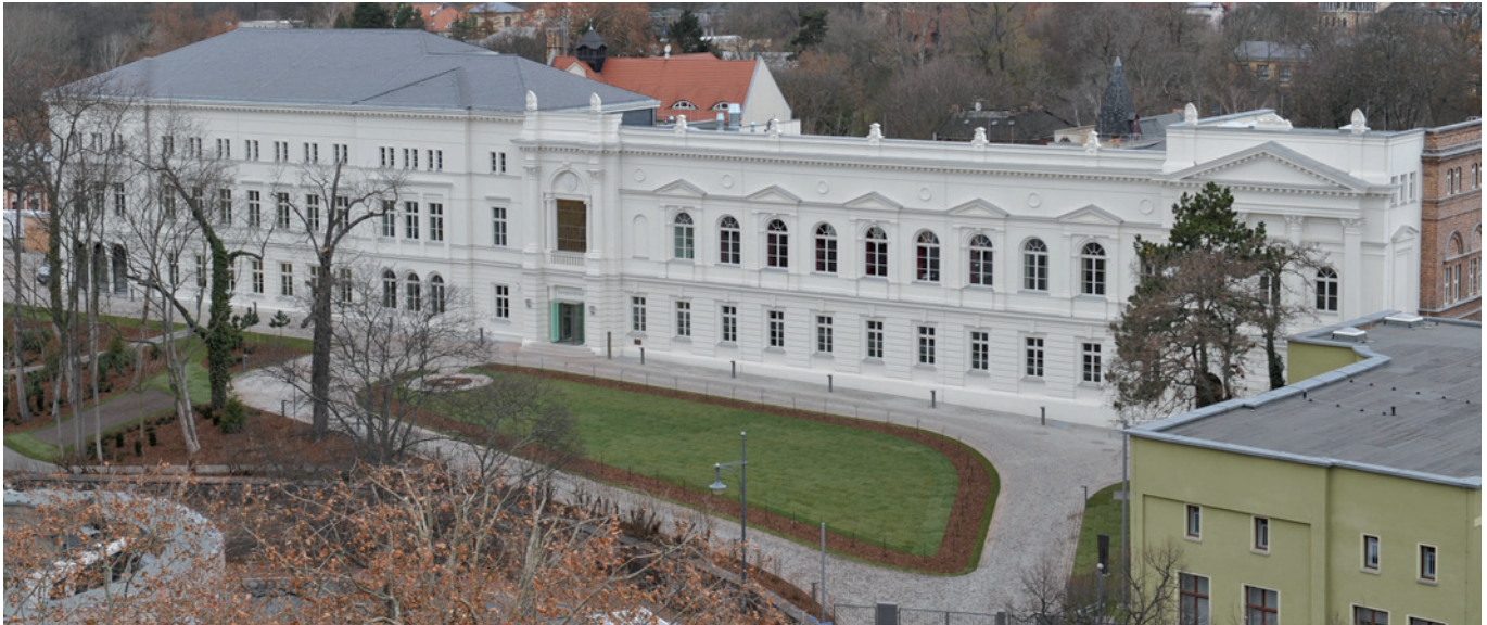
Blick auf die strahlend weiße Fassade und die bereits gestaltete Außenanlage am Tag der Schlüsselübergabe.
